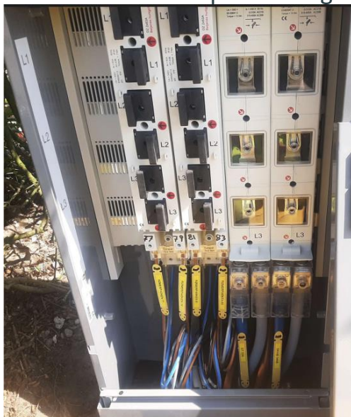
1.A. Korrekt opmærkning og korrekt føring af stikledninger
