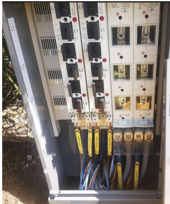
1. A. Korrekt opmærkning og korrekt føring af stikledninger
